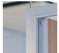
Keine sichtbaren Scharniere durch ein durchgehendes Türband mit verdeckter Drehlagerung
