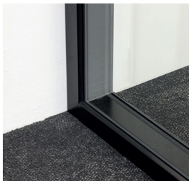
Decken-, Boden- und Wandanschluss zweischalig
