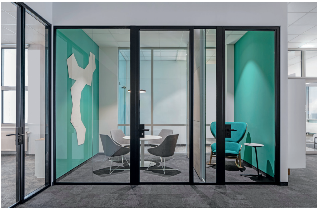
Einschalige Ganzglaswand mit Aluminiumprofilen in RAL 9011 (Graphitschwarz), raumhohe Drehtüren mit Zarge und Bandraaster schlossseitig
