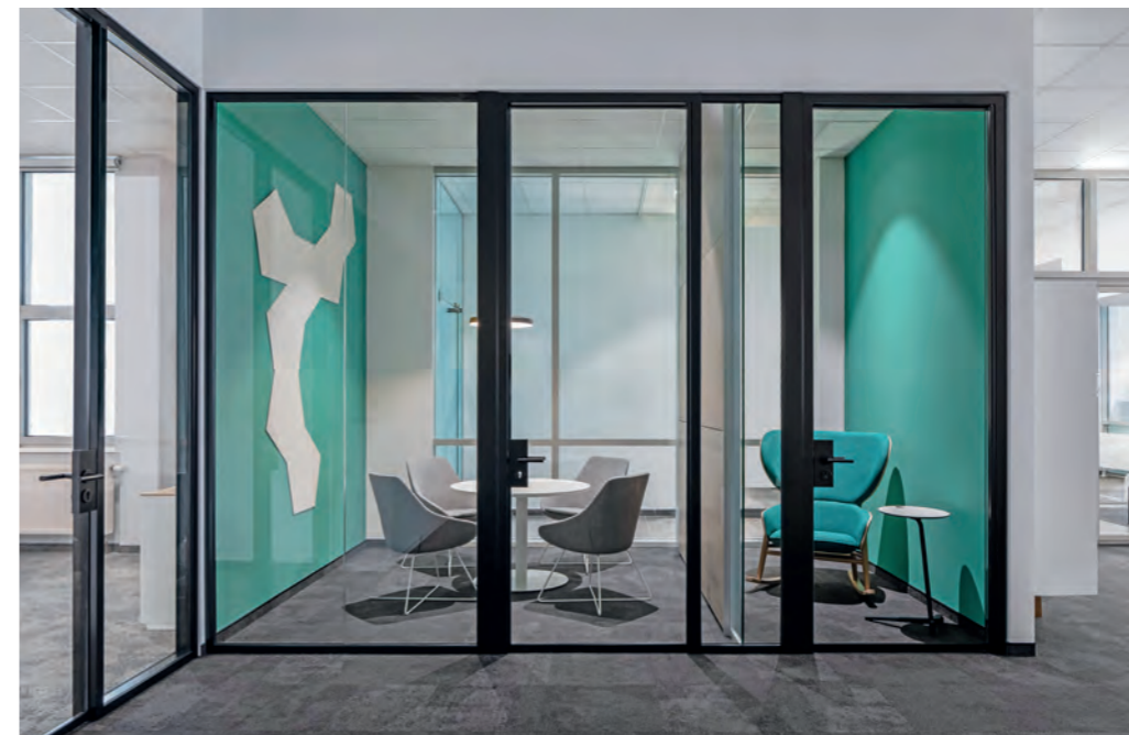
Einschalige Ganzglaswand mit Aluminiumprofilen in RAL 9011 (Graphitschwarz), raumhohe Drehtüren mit Zarge und Bandraster schlossseitig
