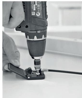
7. Mittelsteg mittels Spanplattenschraube (1 Stück) an die Tischplatte schrauben.
